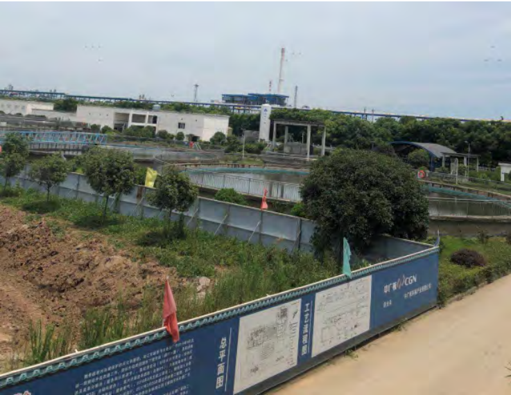
枝江污水处理项目建设现场。
