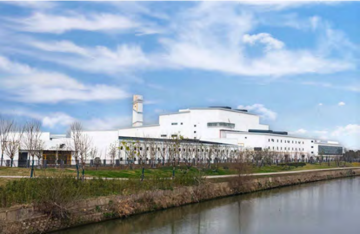
无锡固废处理项目建设现场。
