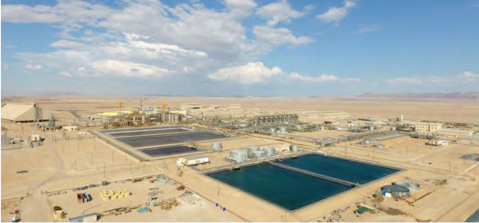
2020 年斯科天然铀矿厂区。
